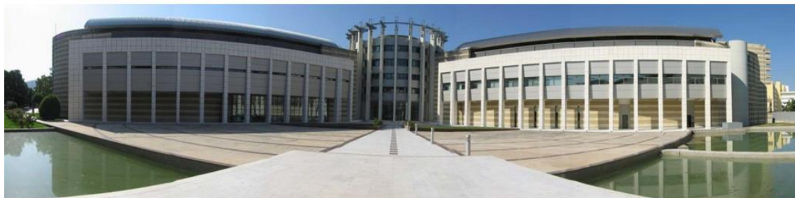
Όψη των εγκαταστάσεων
